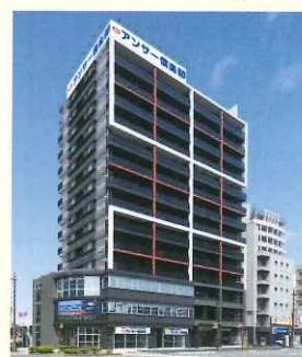
アンサー倶楽部 本社ビル
