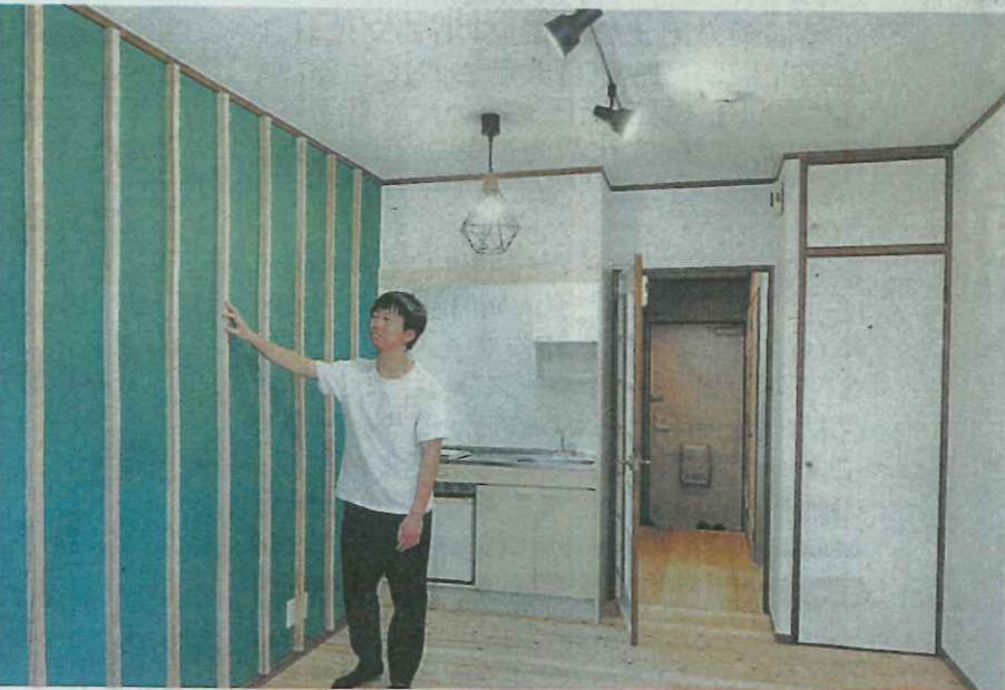
壁に取り付けた角材にくぎやねじを打ち込めば、入居者の好みに応じて棚を作ることができる
